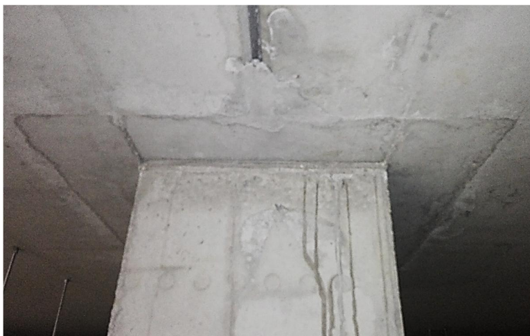
Rys. 5. Widok strefy podporowej od spodu stropu z monolitycznym fragmentem wokół słupa o szerokości 15 cm i stykiem prefabrykatów w osi słupa.
