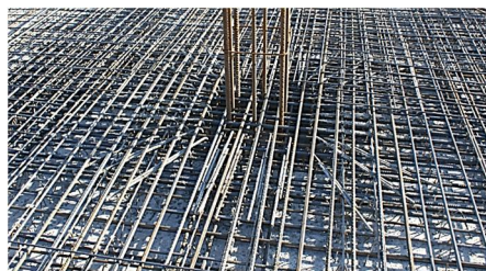
Rys. 8. Szczegół ułożenia zbrojenia w strefie podporowej stropu.
